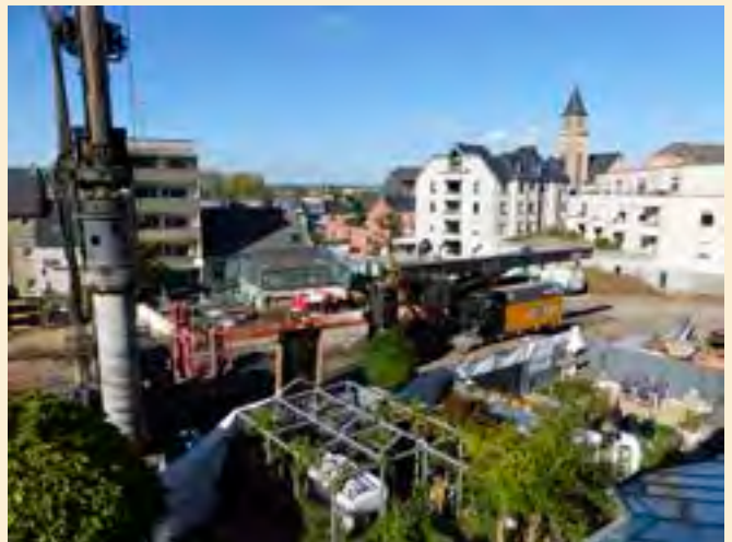
Travaux autour du parking souterrain © M. Gilbert Bock
